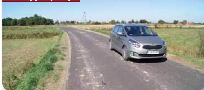
Remont drogi gminnej w Smugach
