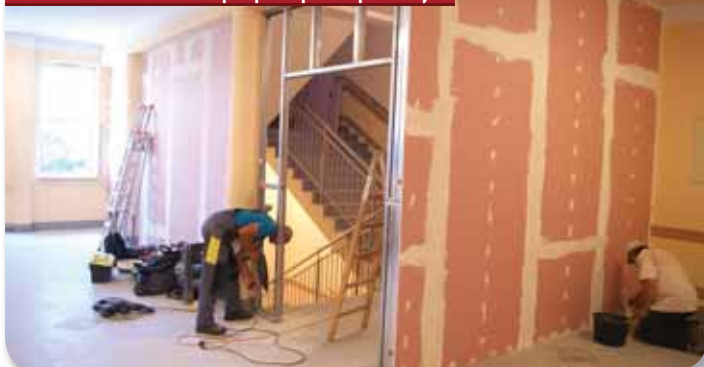
Przebudowa szkoły podstawowej w Tomaszowicach w zakresie dostosowania do przepisów przeciwpożarowych
