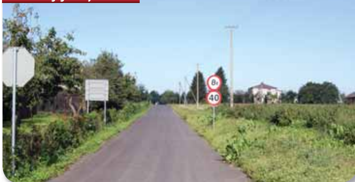
Budowa drogi gminnej w Ożarowie
