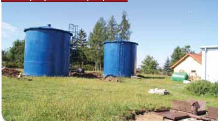
Modernizacja stacji uzdatniania wody w Sieprawkach
