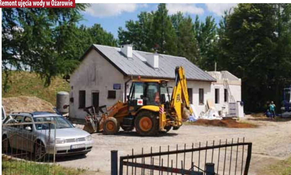
Remont ujęcia wody w Ożarowie
