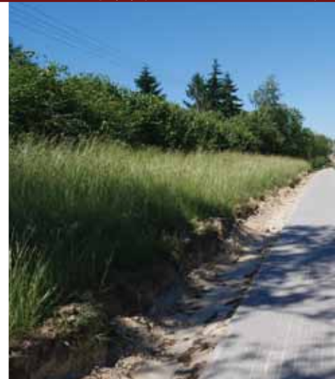
Budowa chodnika przy byłej trasie Lublin - Warszawa w miejscowości Jastków
