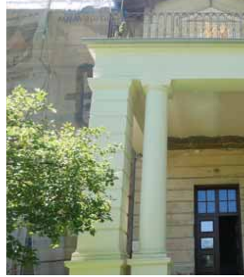
Trwający remont pałacu w Panieńszczyźnie
