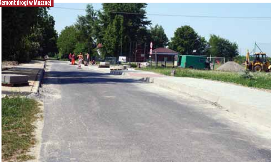
Remont drogi w Mosznej
