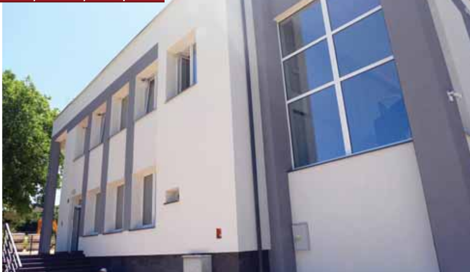
Ukończony remont budynku w Sieprawicach
